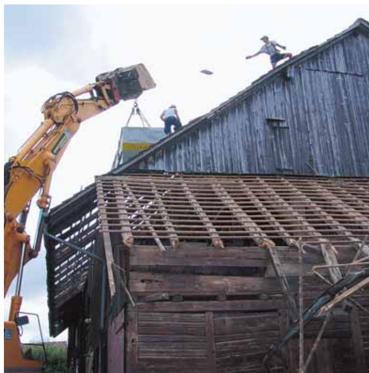
Abbruchvorbereitungen am spätmittelalterlichen Bauernhaus am Teil ohne Baubewilligung. (Bild: Olav Brunner)
