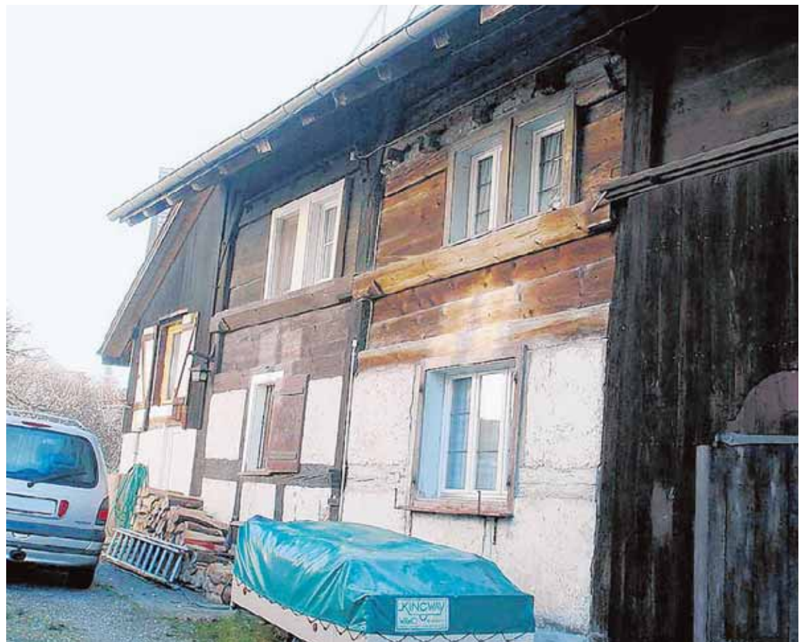
Nordfassade der beiden Wohnteile, die fast vollständig aus Holz gebaut waren und erhalten werden sollten. (zvg)
