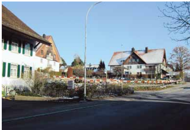
Die Baulücke im Birchwiler Ortskern bleibt wohl noch eine Weile bestehen; zur Zeit ist ein teilweiser Baustopp verfügt.
